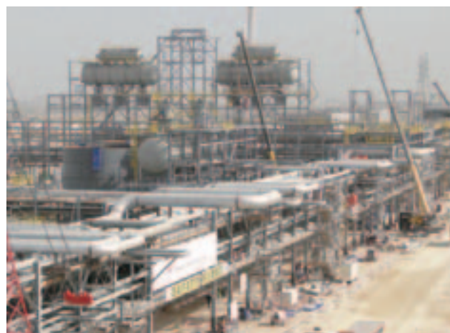
サウジアラビア・ジュベイル製油所プロジェクト
